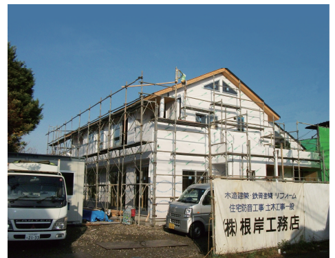
2011年12月 府中 新築工事
